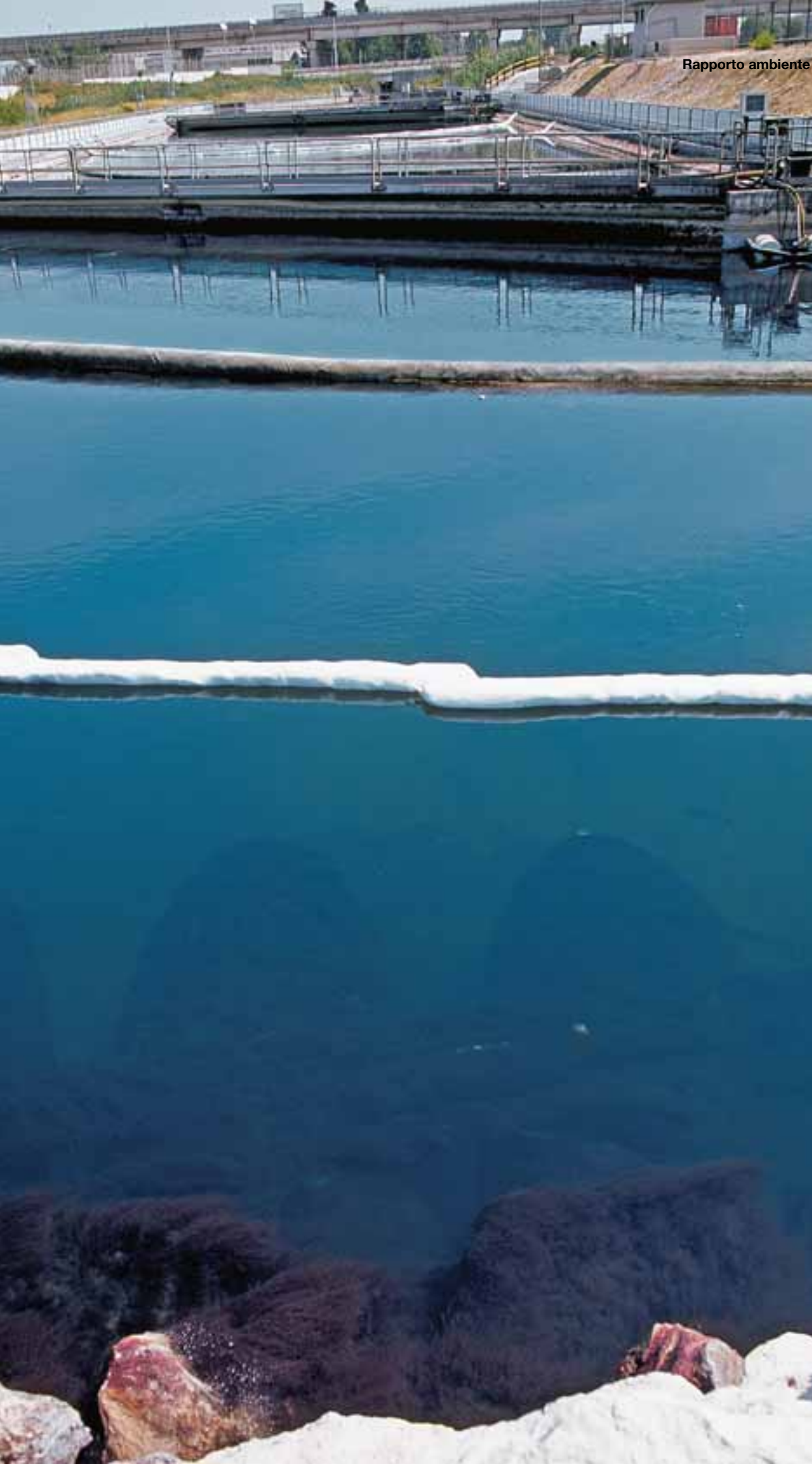
Figura 102 Secondo canale di scarico
