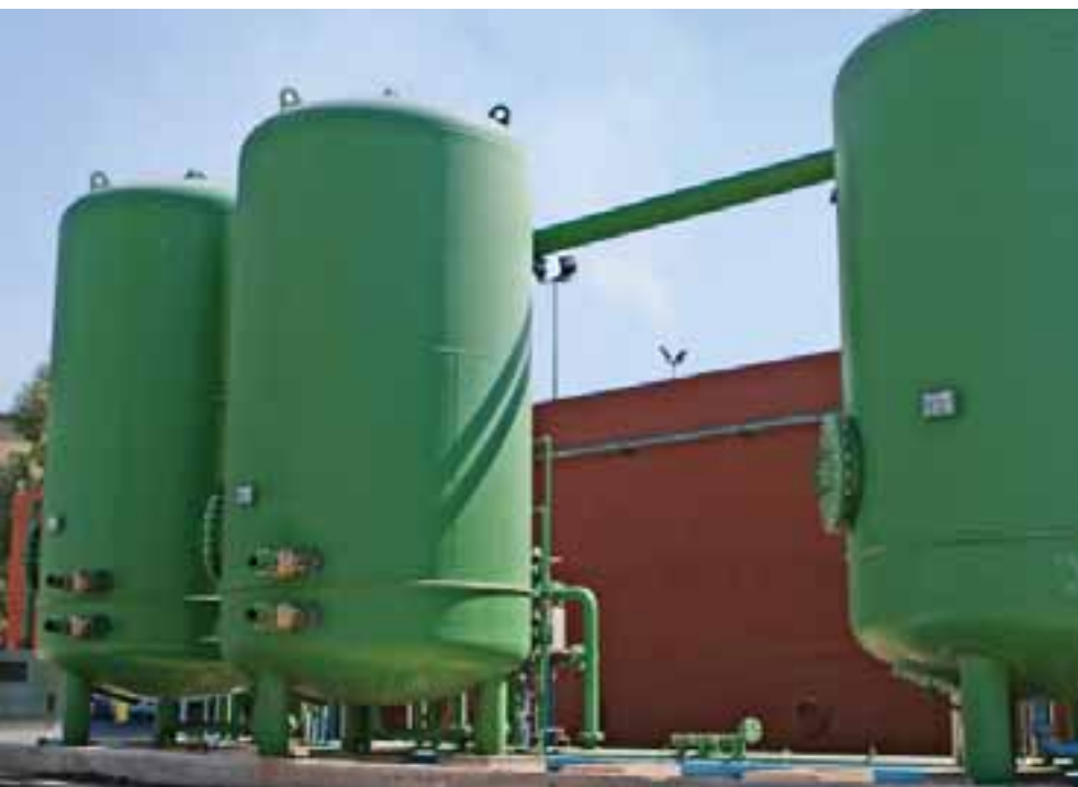
Figura 46 Filtro a sabbia e carbone treno nastri 2
