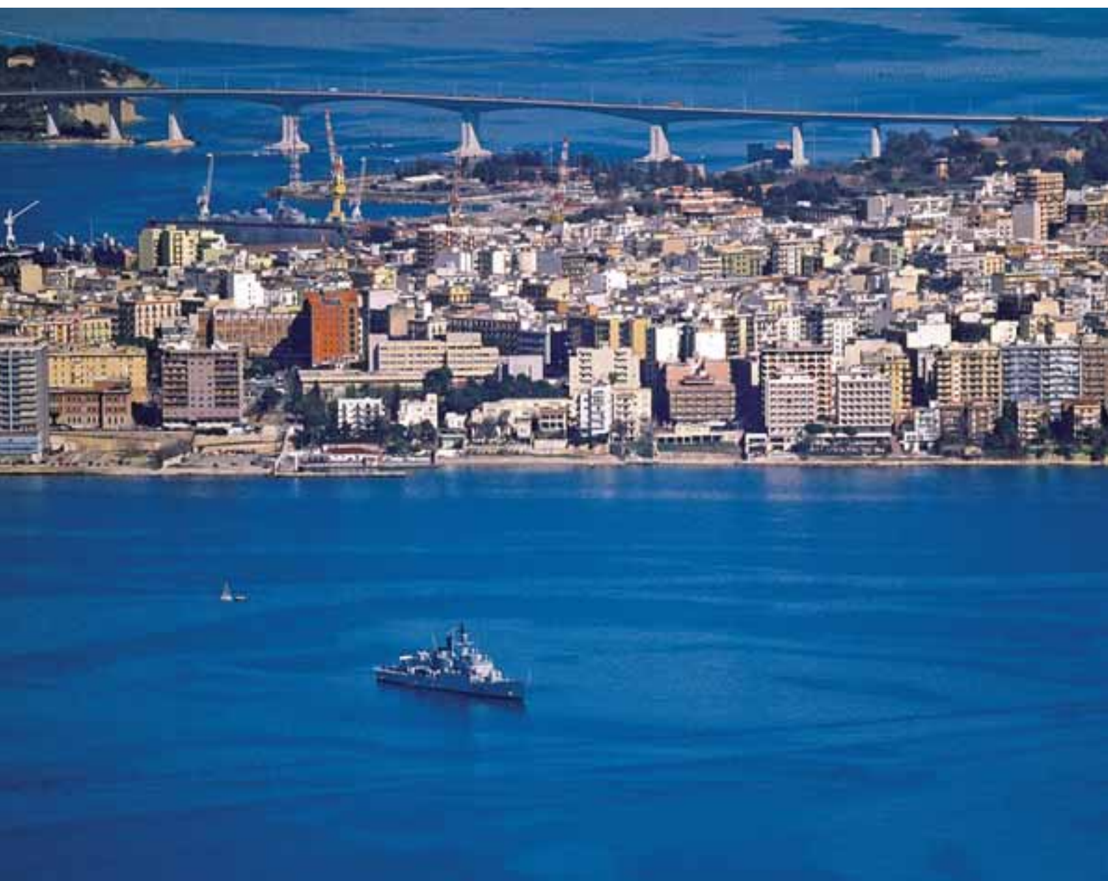
Figura 71 Vista panoramica della città
