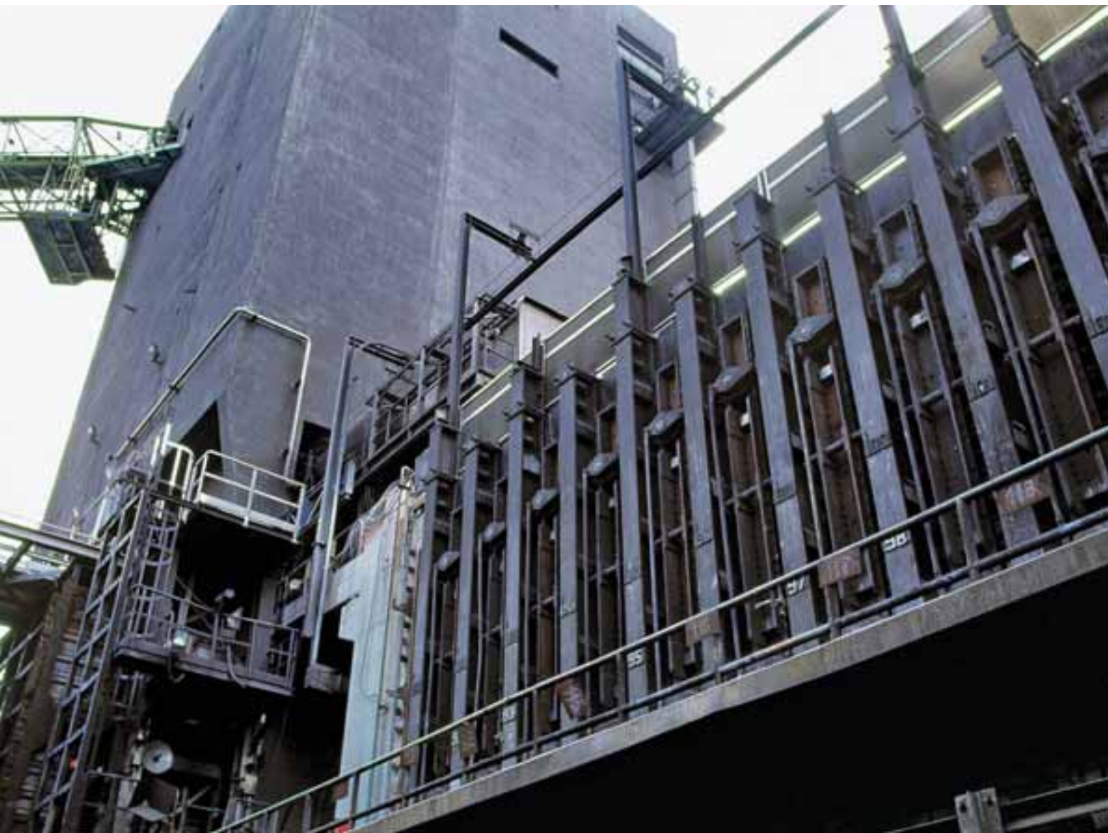
Figura 54 Batteria forni a coke
