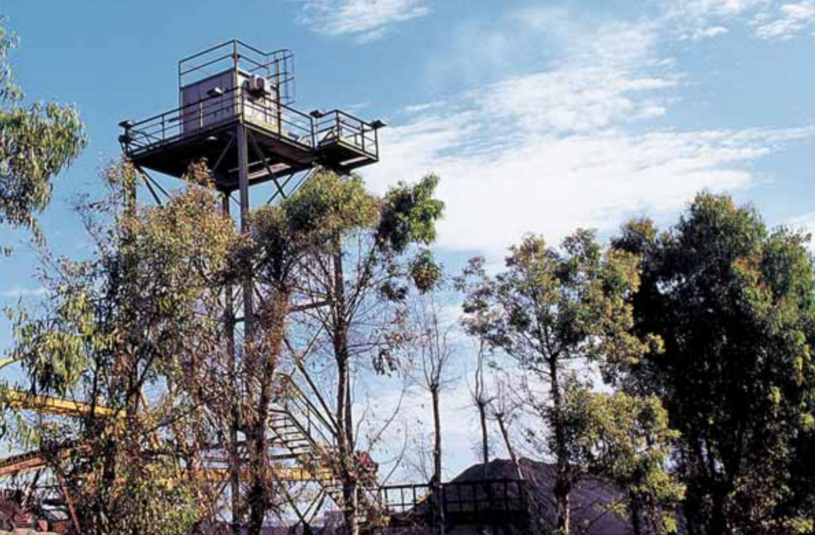
Figura 82 Centralina di monitoraggio della polverosità
