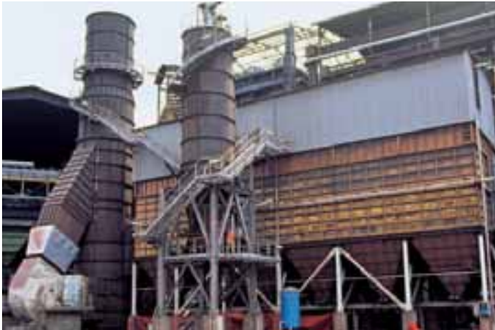
Figura 32 Impianto depolverazione stock-house AFO 5
