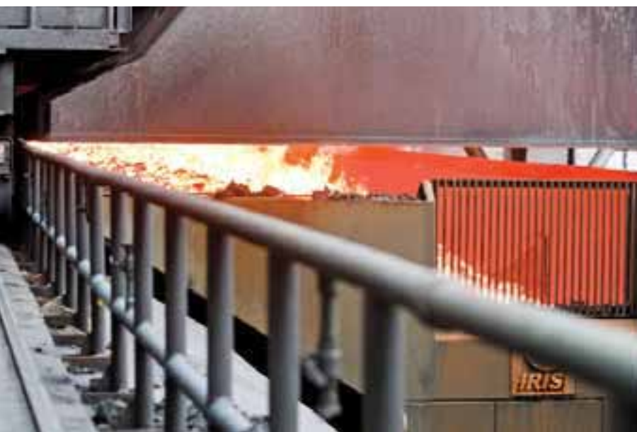
Figura 69 Fase aspirazione fumi allo sfornamento del coke
