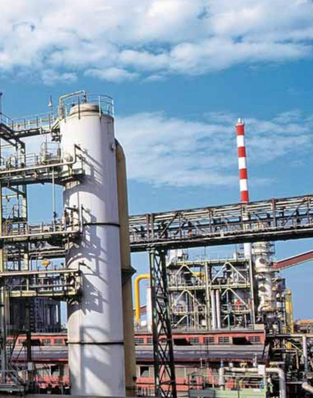
Figura 87 impianto desolforazione gas coke
