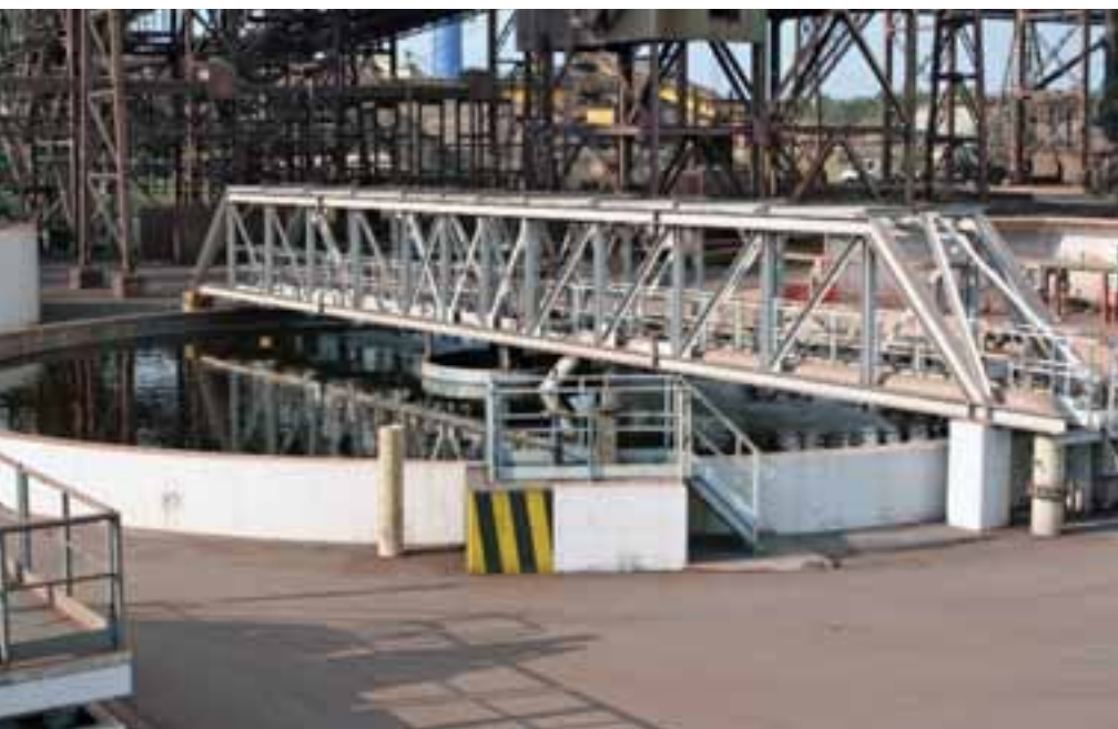
Figura 99 Decantatore circolare
