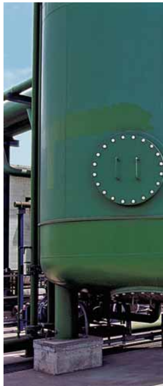
Figura 100 Filtri a sabbia e a carbone
