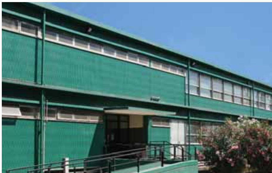
Figura 154 Palazzina "Scuola di formazione"
