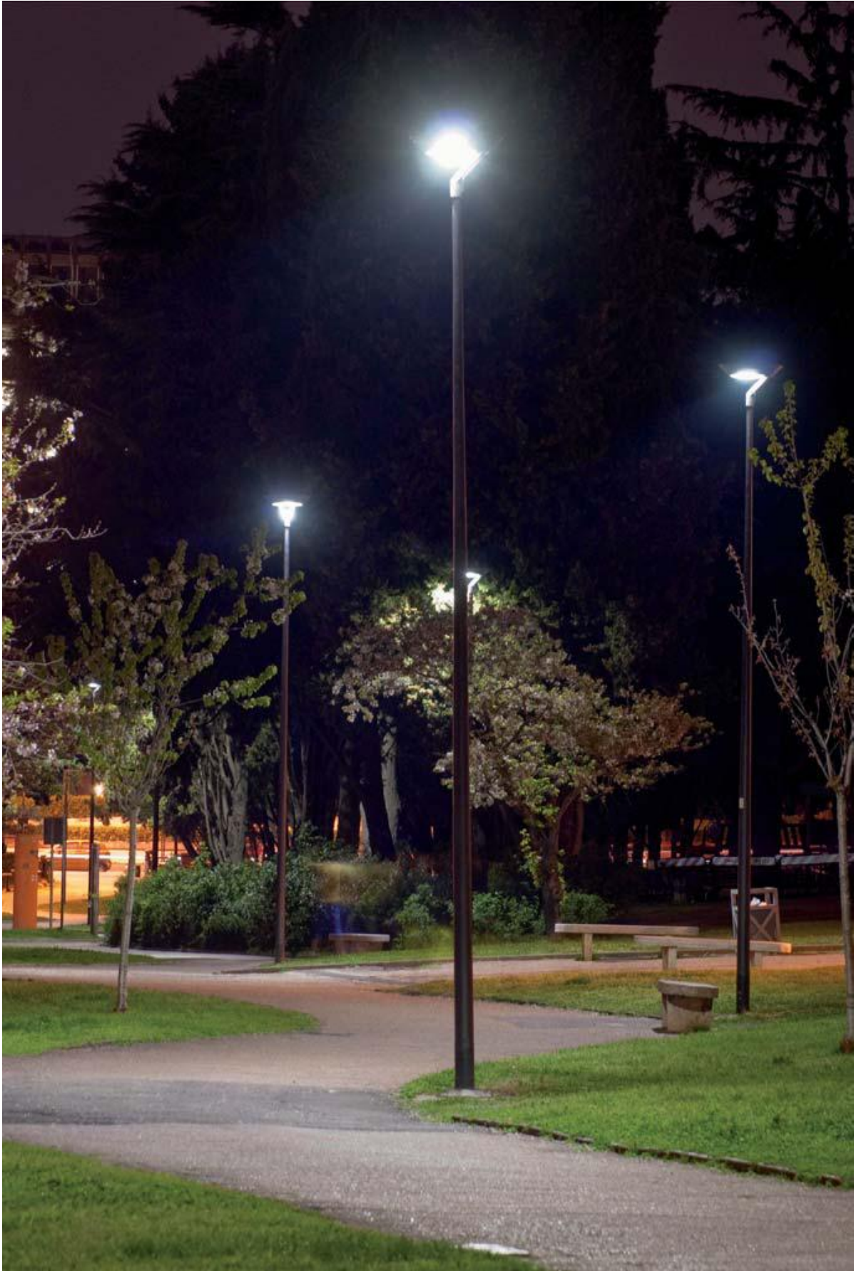
I giardini del Laghetto dell'Eur a Roma, installazione LedGine
