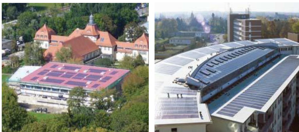
Foto 7a e 7b: Esempi di coperture verdi e fotovoltaici sulla membrana di copertura
