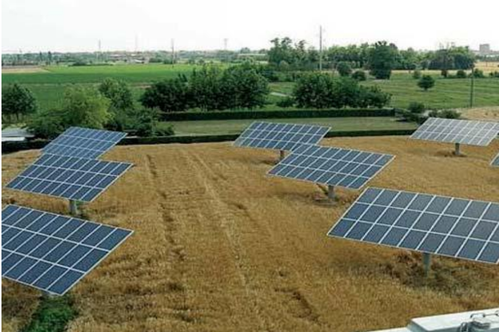
Foto 2: Moduli fotovoltaici nell'anello agricolo
