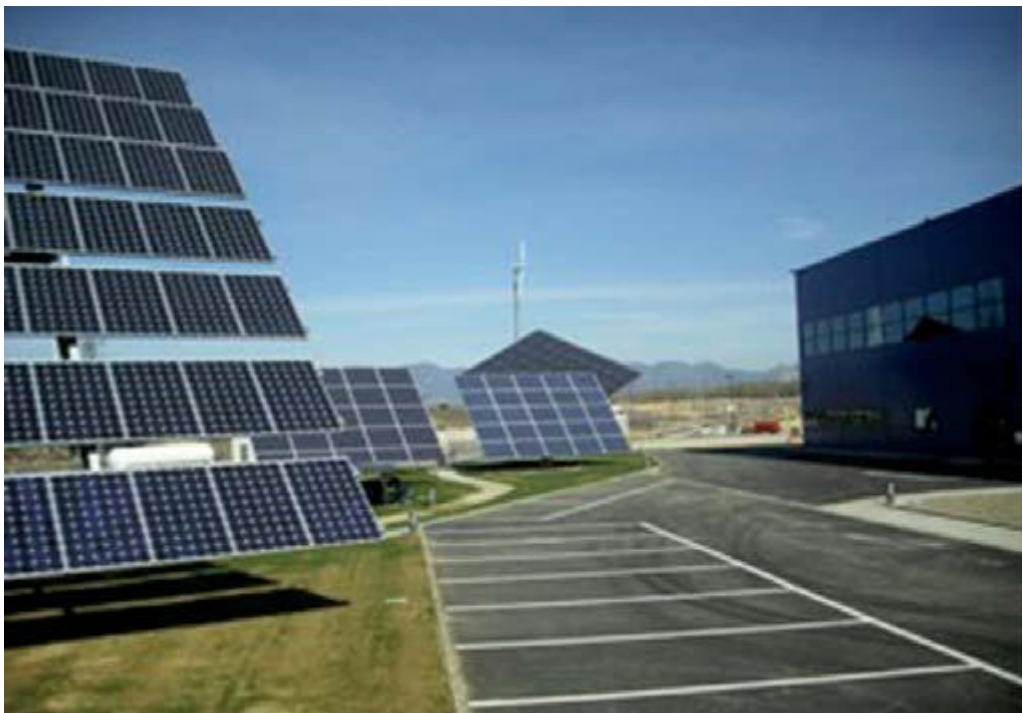
Foto 1: Il Parco tecnologico di Walqa
