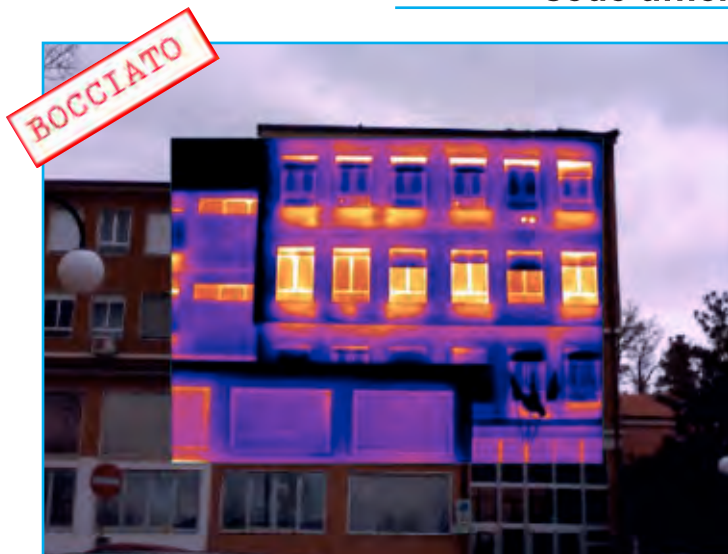
Edificio comunale, facciata principale
