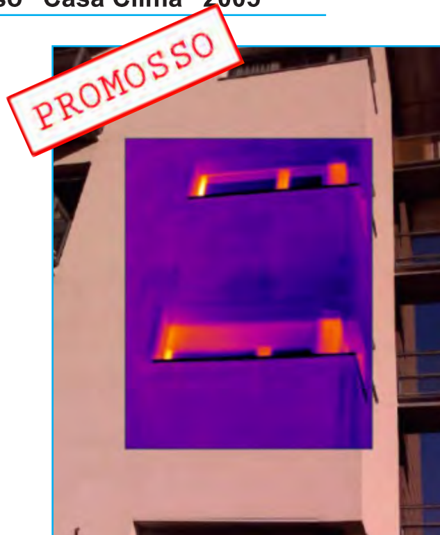
Facciate sud ovest
