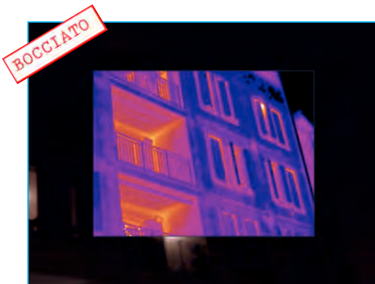
Particolare della facciata ovest, terrazzino
