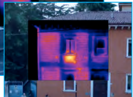
Dettagli della facciata Sud est
