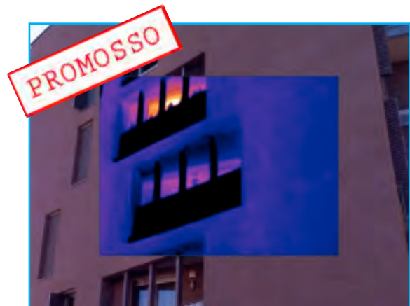
Dettagli facciata nord-est
