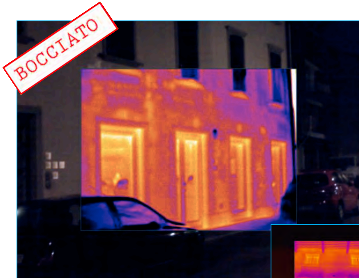
Particolare della facciata fronte strada piano terra lato sud
