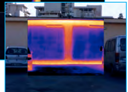
Particolare struttura muraria, nord
