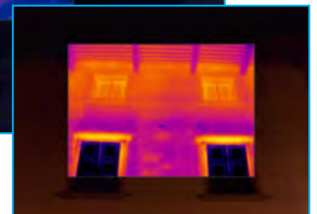
Particolare della facciata, mansarda, lato sud
