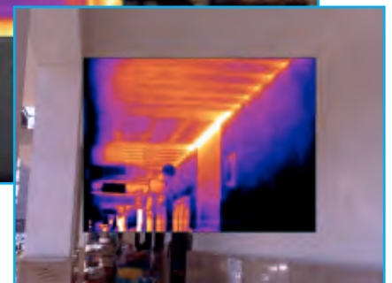
Solaio portico esterno facciata Est
