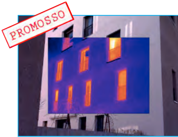
Dettagli facciata nord-est
