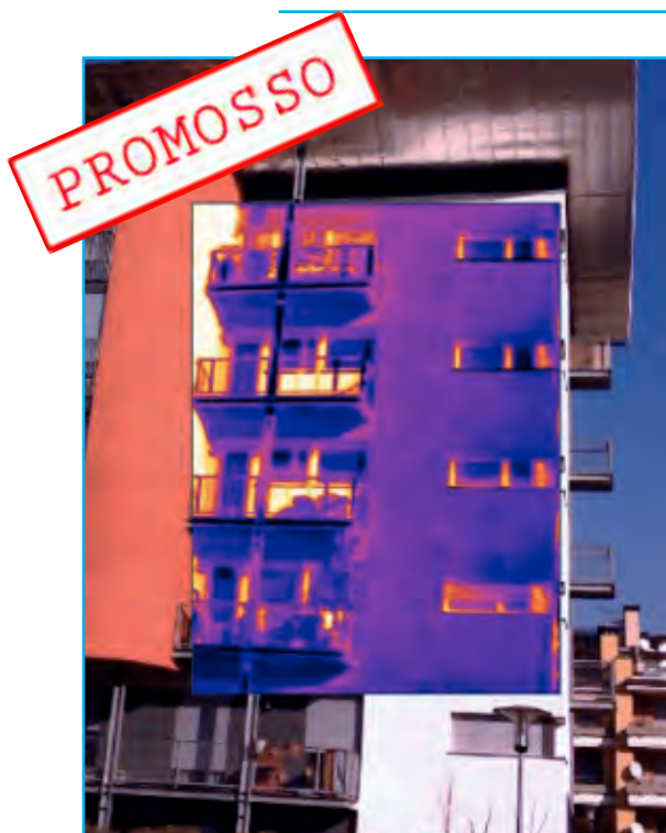
Facciate sud ovest
