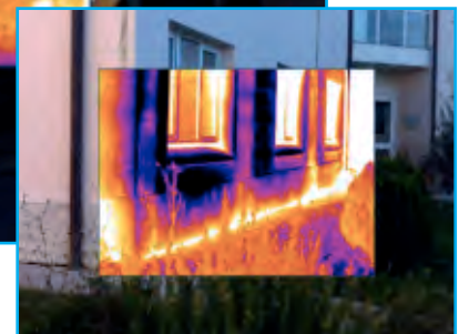
Particolare perimetro esterno
