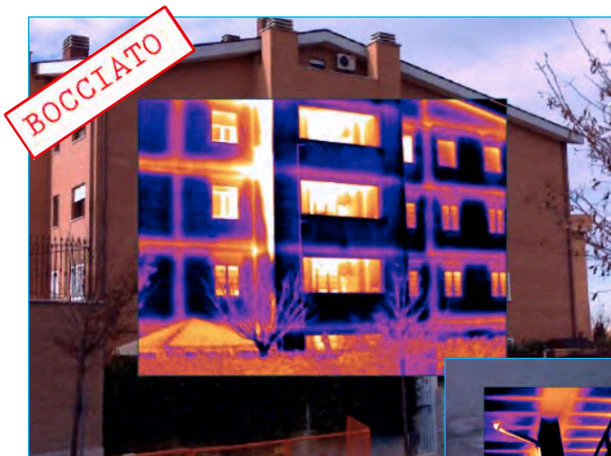
Edificio residenziale Malafede, facciata Est - Comune di Roma
