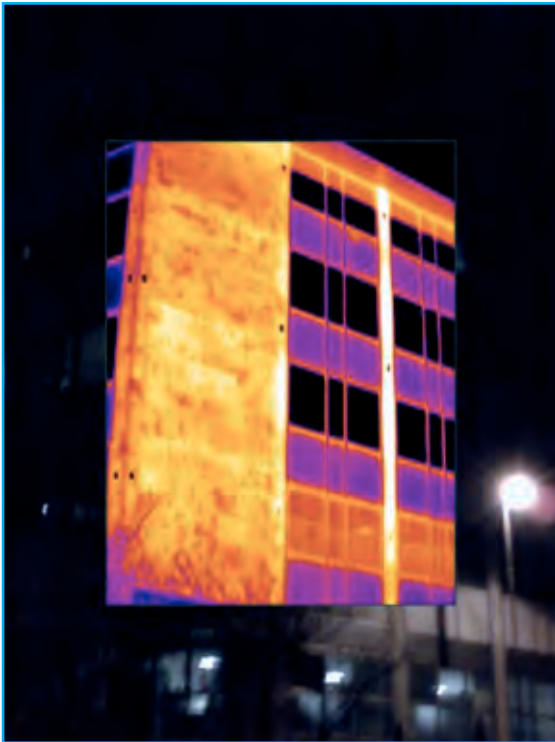
Particolare struttura muraria facciata principale
