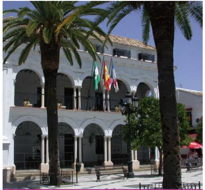
Imagen del centro urbano de Almonte
