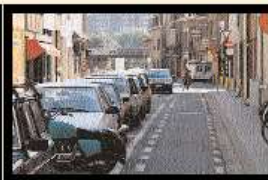
Dove il traffico è intenso, la corsia contromano è realizzata tra il marciapiede e i parcheggi.
