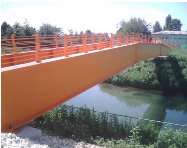
passerella ciclopedonale zona piscine
