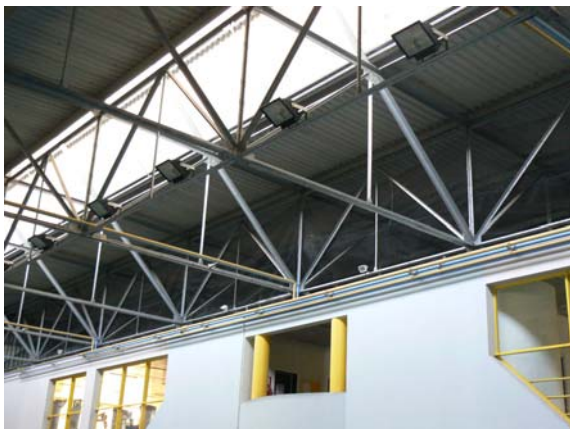
PROIETTORI NEL CAMPO DA GIOCO E LAMPADIE FLUORESCENTI TUBOLARI NEGLI ALTRI LOCALI
