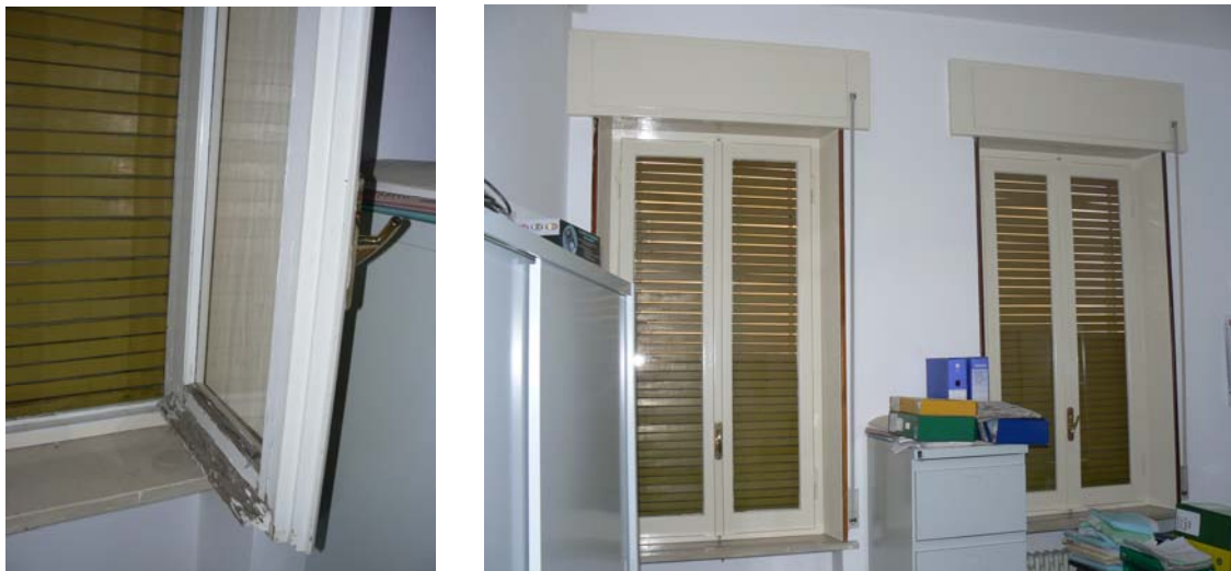
FINESTRE IN LEGNO E VETRO SEMPLICE SUL LATO SUD – EST DELL'EDIFICIO
