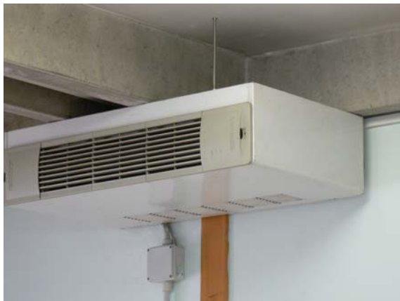
CALDAIA IN CENTRALE TERMICA E VENTILCONVETTORI NEI LOCALI
