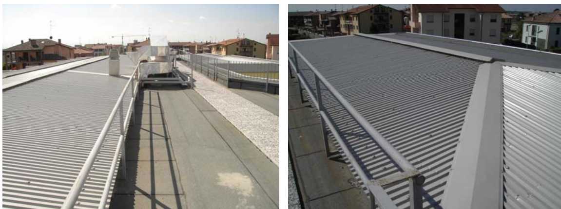
COPERTURA PIANA E COPERTURA IN LAMIERA DEL CORPO AULE DELLA SCUOLA
