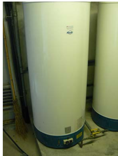
CALDAIA E SCALDACQUA AD ACCUMULO IN CENTRALE TERMICA
