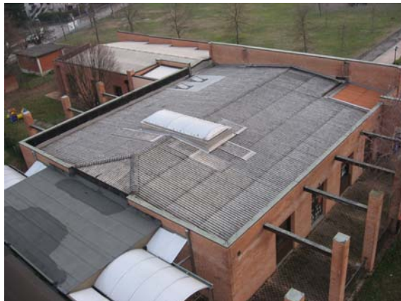
COPERTURA IN LASTRE METALLICHE (A SINISTRA) E IN LASTRE DI CEMENTO E AMIANTO (A DESTRA)
