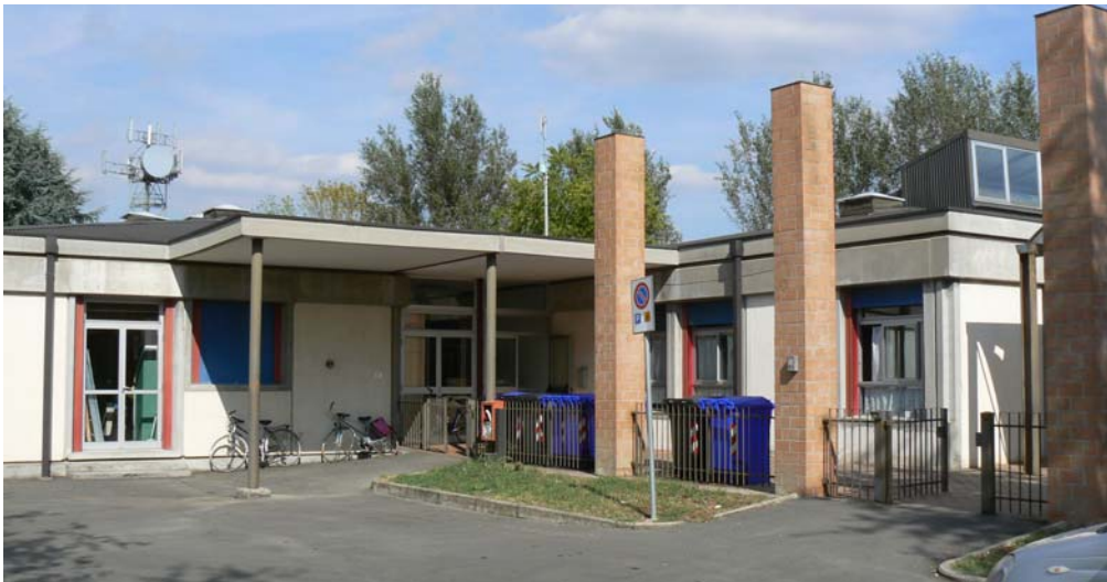
INGRESSO OVEST ALLA SCUOLA MATERNA
