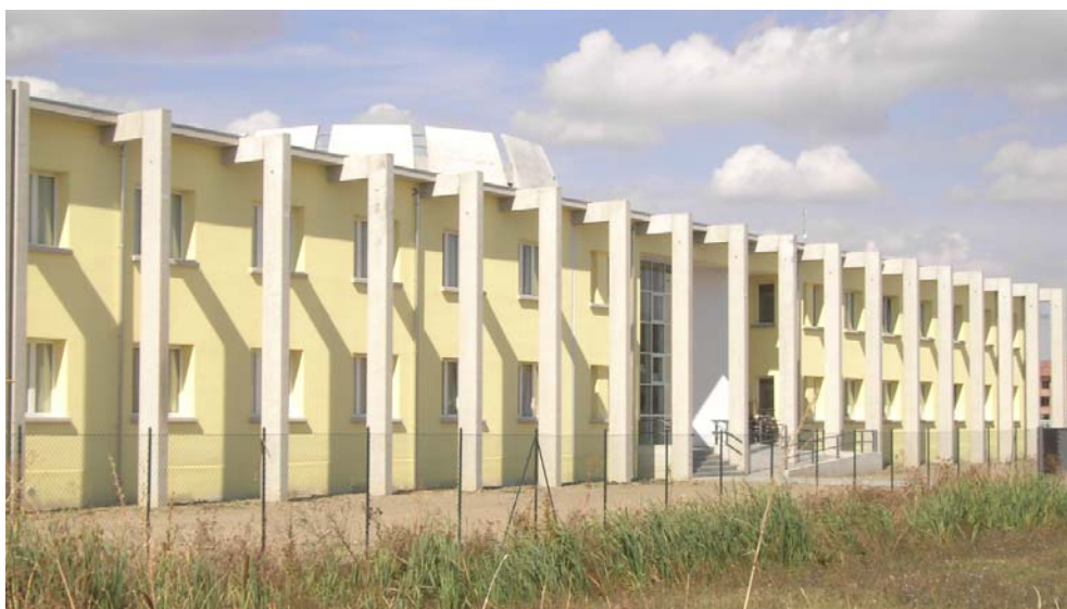
LATO SUD DELLA SCUOLA MEDIA
