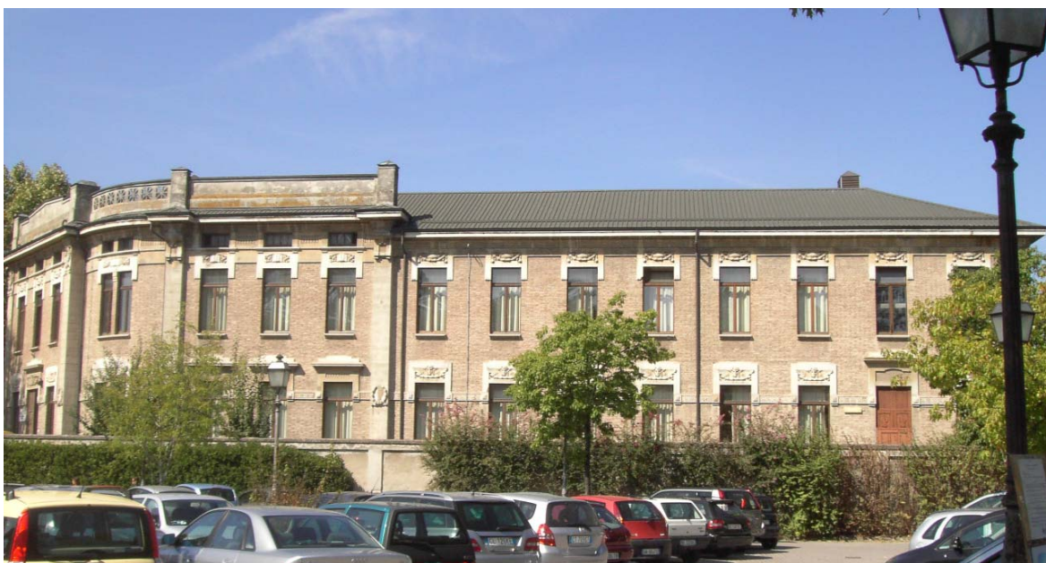
CORPO PRINCIPALE (AULE E ALTRI SPAZI DIDATTICI) DELLA SCUOLA
