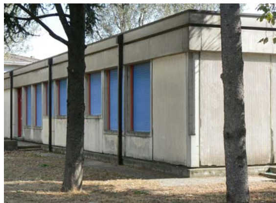
MURATURE IN PANNELLI DI CEMENTO DEL PRIMO NUCLEO DELL'EDIFICIO
