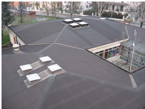
COPERTURA IN LASTRE METALLICHE (A SINISTRA) E IN LASTRE DI CEMENTO E AMIANTO (A DESTRA)
