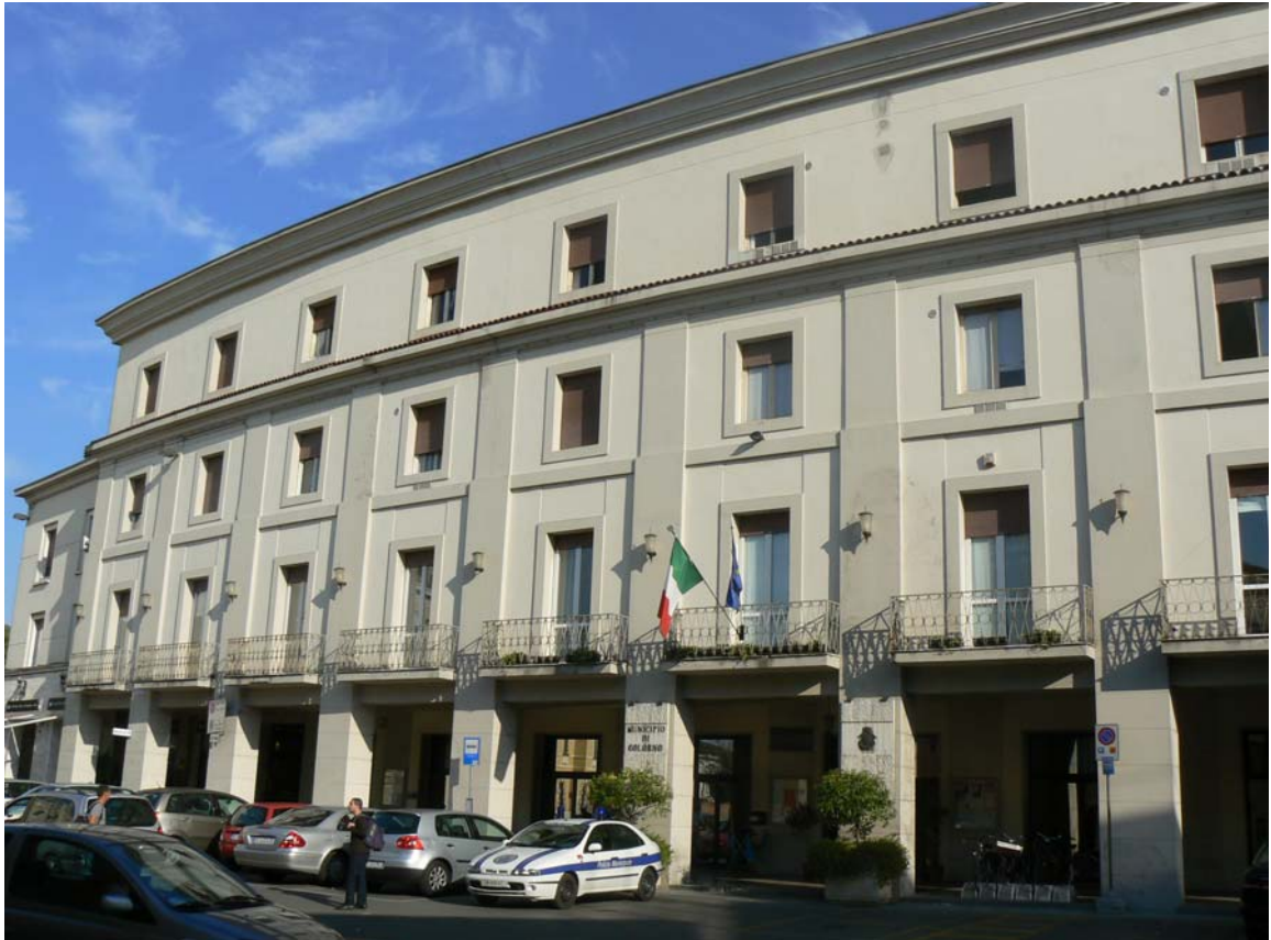
LATO NORD – OVEST DELL'EDIFICIO SU VIA CAVOUR
