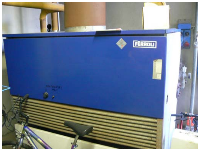
CALDAIA E SCALDACQUA AD ACCUMULO IN CENTRALE TERMICA
