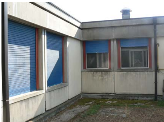
MURATURE IN PANNELLI DI CEMENTO DEL PRIMO NUCLEO DELL'EDIFICIO
