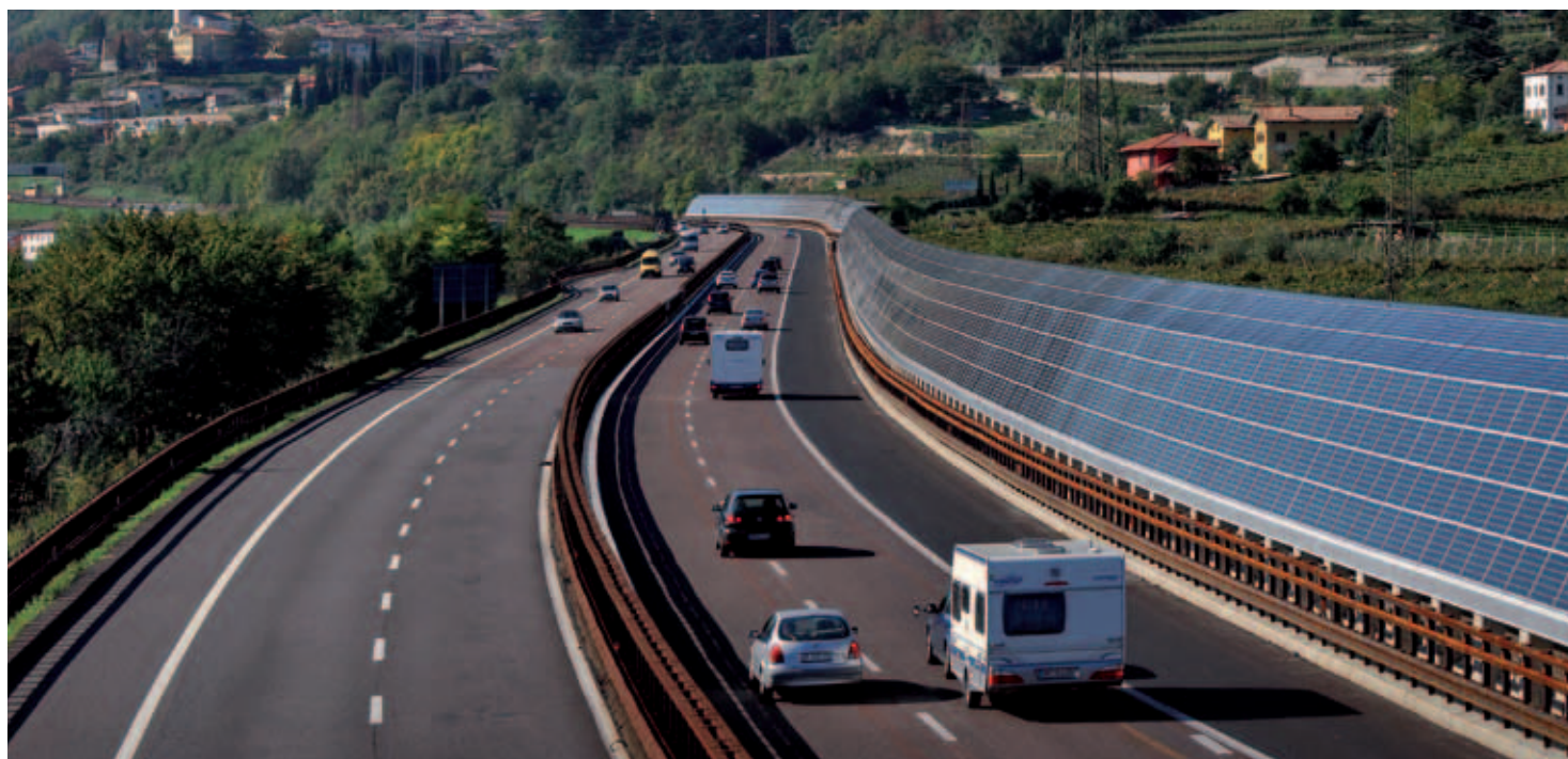
Impianto fotovoltaico su pannello fonoassorbente, autostrada A22, Comune di Isera
