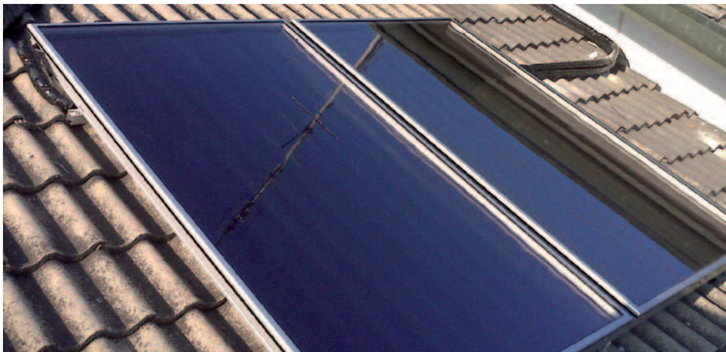
Impianto solare termico installato tramite gruppi di acquisto solare, Comune di Padova
