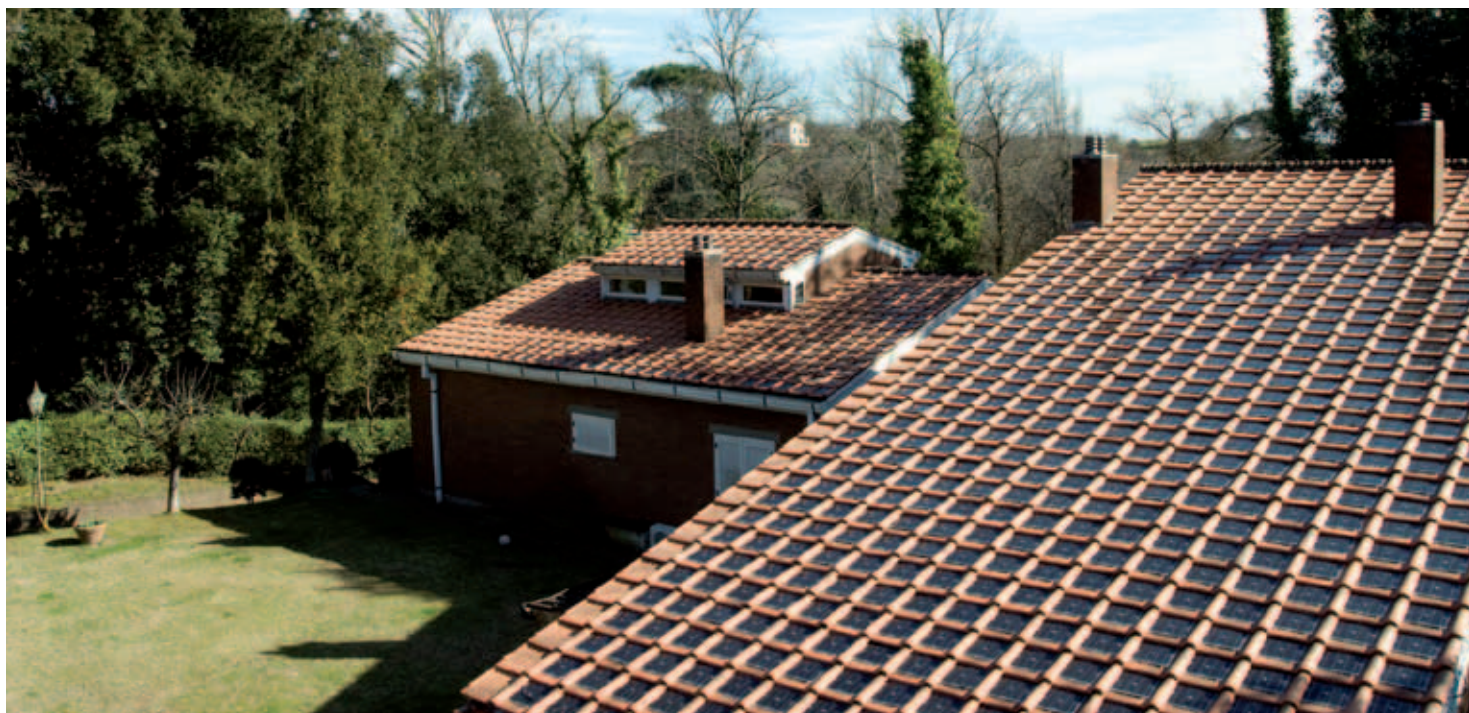
Copertura fotovoltaica ad elettrotegole, Comune di Roma, foto di Horus srl
