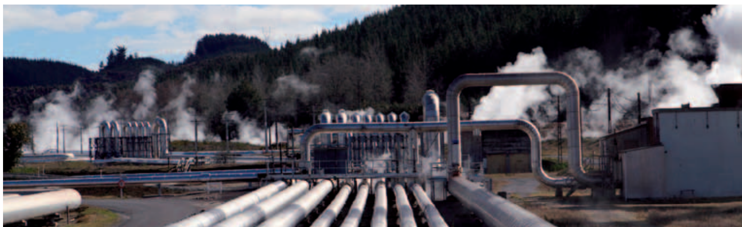
Particolare di rete di teleriscaldamento
