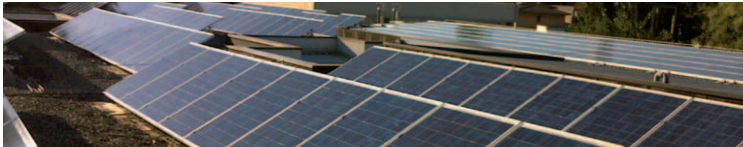
Impianto fotovoltaico in sostituzione di eternit, Comune di Lugo
