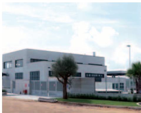
Impianto a biomasse; Comune di Calimera
