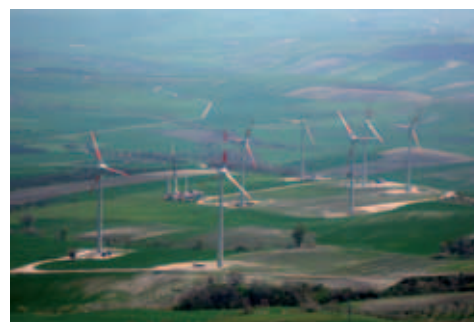
Impianto eolico a Castelnuovo della Daunia (Fg)
