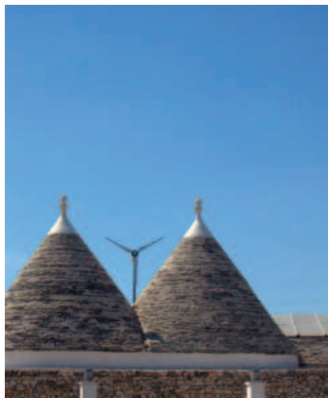
Impianto mini eolico, Comune di Martina Franca
