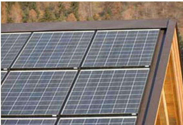
Ubicazione / Site Perca (BZ) Potenza / Capacity 60 kW p
