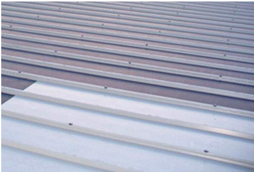
Ubicazione / Site Sellero (BS) Potenza / Capacity 20 kW p
