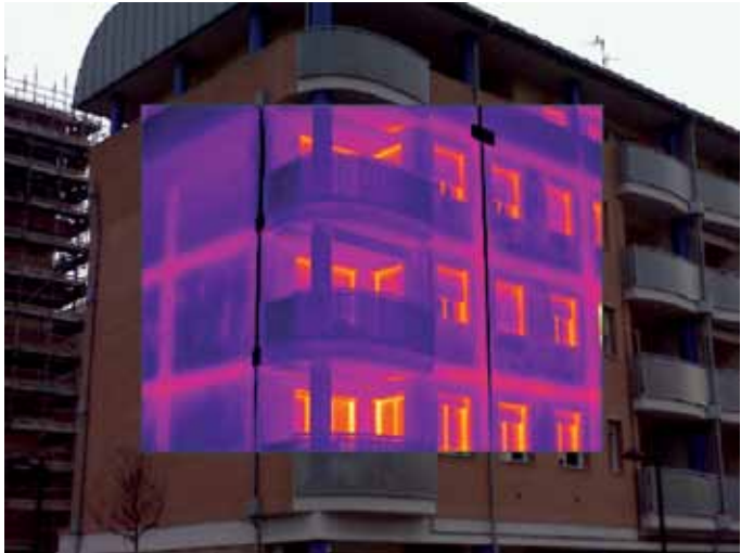
BOLOGNA - VIA ZANOLINI, ANNO 2010 TEMPERATURE DISOMOGENEE SULLE FACCIATE E PONTI TERMICI IN CORRISPONDENZA DELLE STRUTTURE PORTANTI >>
