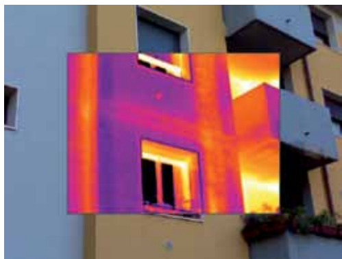
PADOVA - EDIFICIO RESIDENZIALE ANNO 2009 DISPERSIONI LOCALIZZATE SUL TELAIO PORTANTE >>
