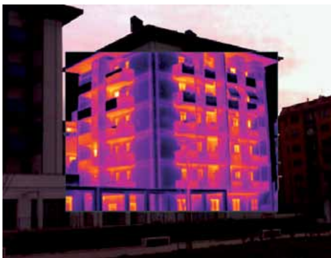
FIRENZE - VIA CANOVA ANNO 2010 EDIFICIO PUBBLICIZZATO CON PRESTAZIONI ENERGETICHE DI CLASSE A IN EVIDENZA I PONTI TERMICI DI TRAVI E PILASTRI PORTANTI
