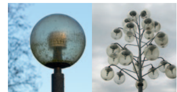
Kugelleuchten sind zwar dekorativ, aber beleuchtungstechnisch völlig ineffizient.
