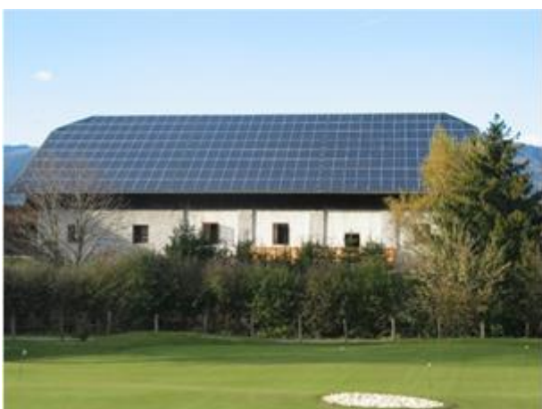
impianto su capannone
