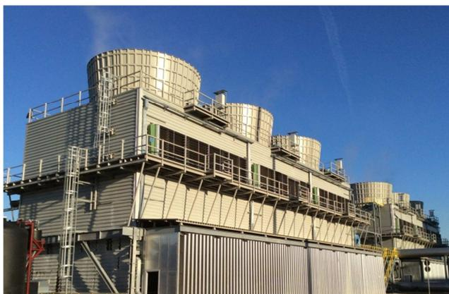
produce l'energia dalla combustione dei rifiuti grazie alla presenza delle turbina e del successivo generatore. L'aria espulsa in atmosfera è più calda e più umida di quella ambiente. È questa la natura del **vapore (o nebbia)** che esce dalle torri evaporative. Per questo motivo, è errato definirla fumo poiché questo termine si associa più propriamente a gas di scarico. **La formazione e la visibilità del**
