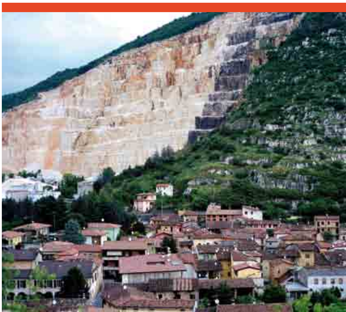
Comune di Mazzano (Bs)
