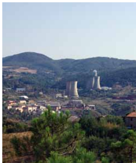
Impianto ad alta entalpia di Larderello nel Comune di Pomarance (PI)
