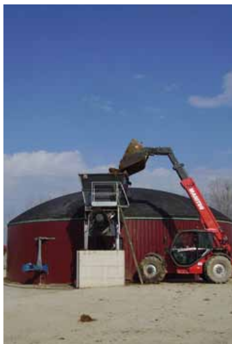
Esempio di impianto a biogas
