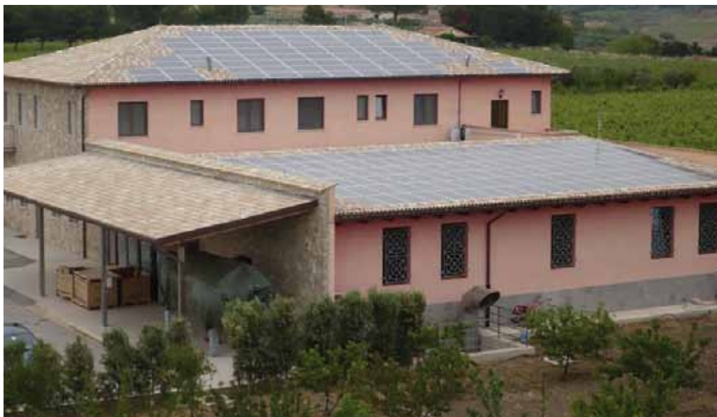
Impianto fotovoltaico Tenuta Menfi (AG)
