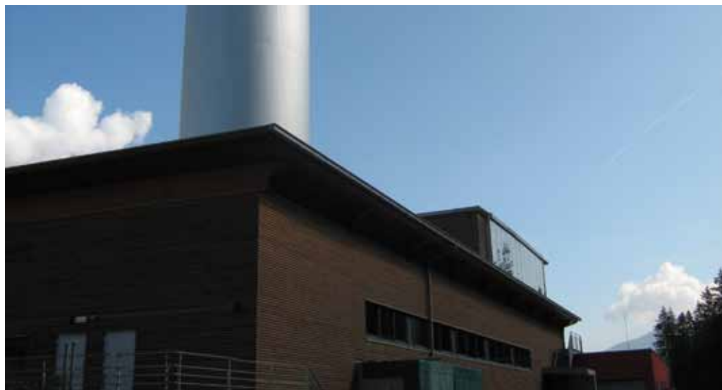
Impianto di teleriscaldamento, Comune di Dobbiaco (BZ)
