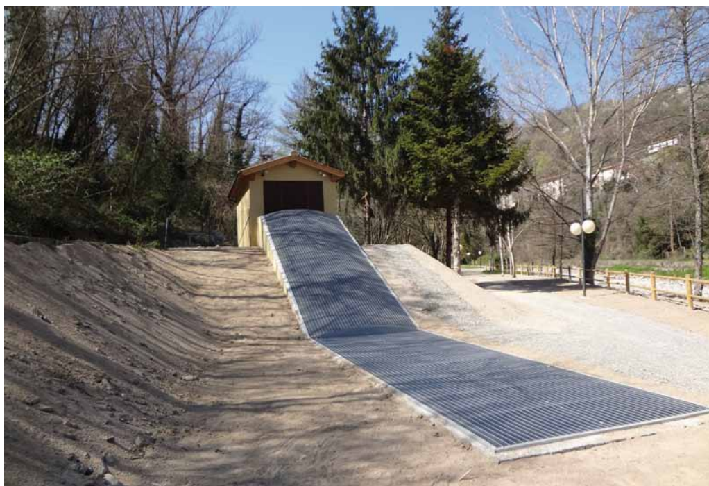
Impianto mini idroelettrico, Comune di Prato
