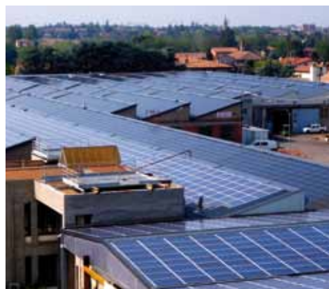
Impianti fotovoltaici, Comune di Castelvetro (MO)
