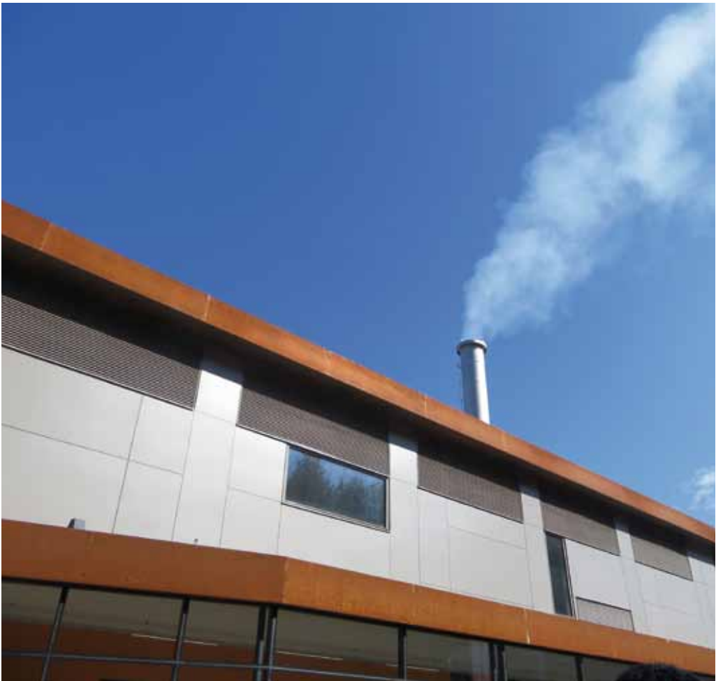
Impianto a biomassa Comune di Dobbiaco (BZ)
