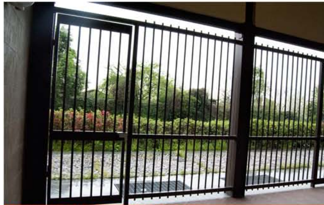
accesso dalla strada interna
