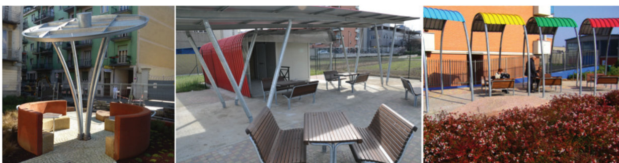
Figura 25: Coperture rigide presso giardino Carpano, orti Urbani di Via Sansovino 205, giardino Marisa Belisario - Torino
