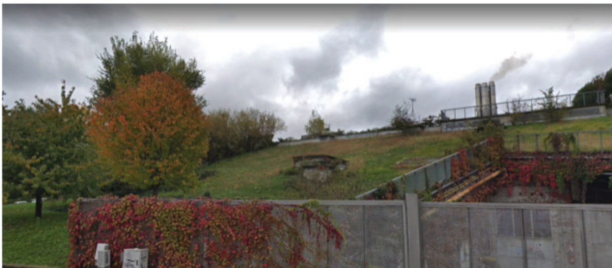
Figura 13: Facciate e coperture verdi presso l'area dell'Environment Park - Torino
