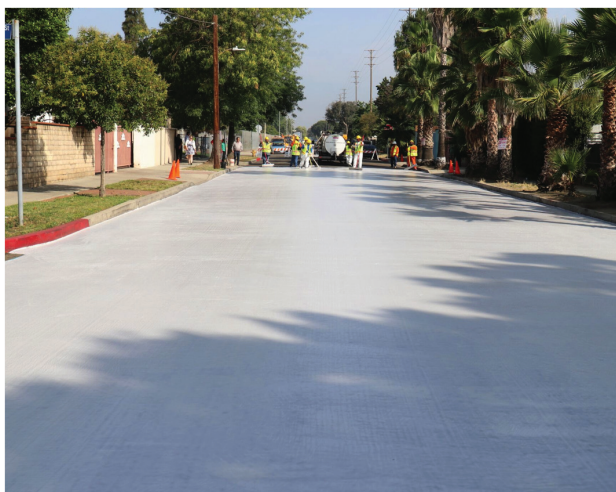
Figura 12: Esempio di pavimentazione in asfalto con rivestimento ad elevato albedo - Los Angeles, California
