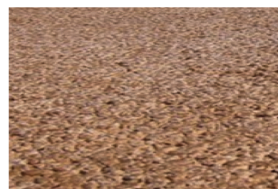
Figura 10: Esempio di pavimentazione in cls drenante
