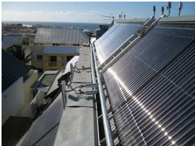
Campo collettori e torre evaporative del sistema di solar cooling installato a Saint Denis de la Réunion, Francia
