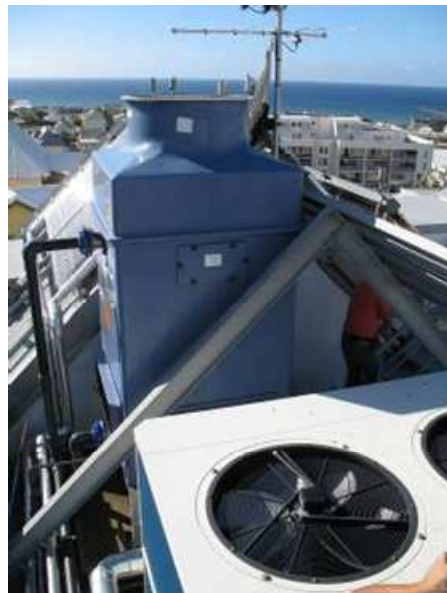
Campo collettori e torre evaporative del sistema di solar cooling installato a Saint Denis de la Réunion, Francia
