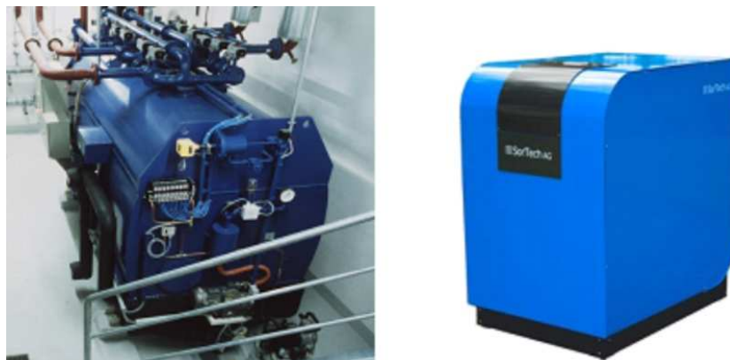
Figura 2.6 Esempi di macchine ad adsorbimento. Sinistra : condizionatore da 70 kW della casa produttrice giapponese Nishiyodo. Macchine di simile potenza sono prodotte da un'altra compagnia giapponese, la Mayekawa. Destra : Condizionatore ad adsorbimento di piccola taglia, circa 7,5 kW, della SorTech, Germania.
