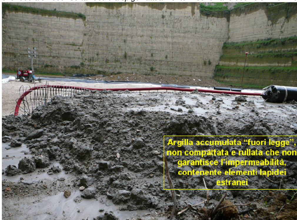
Figura 4: esempio di argilla non compattata e rullata, fotografata il 6 febbraio 2009, su cui attualmente poggiano diverse decine di metri di rifiuti, simile a quella osservata durante il sopralluogo del 28 giugno c.a..
